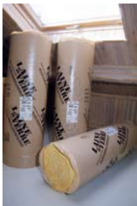
Isolément de combles aménagés avec de la laine de verre.
